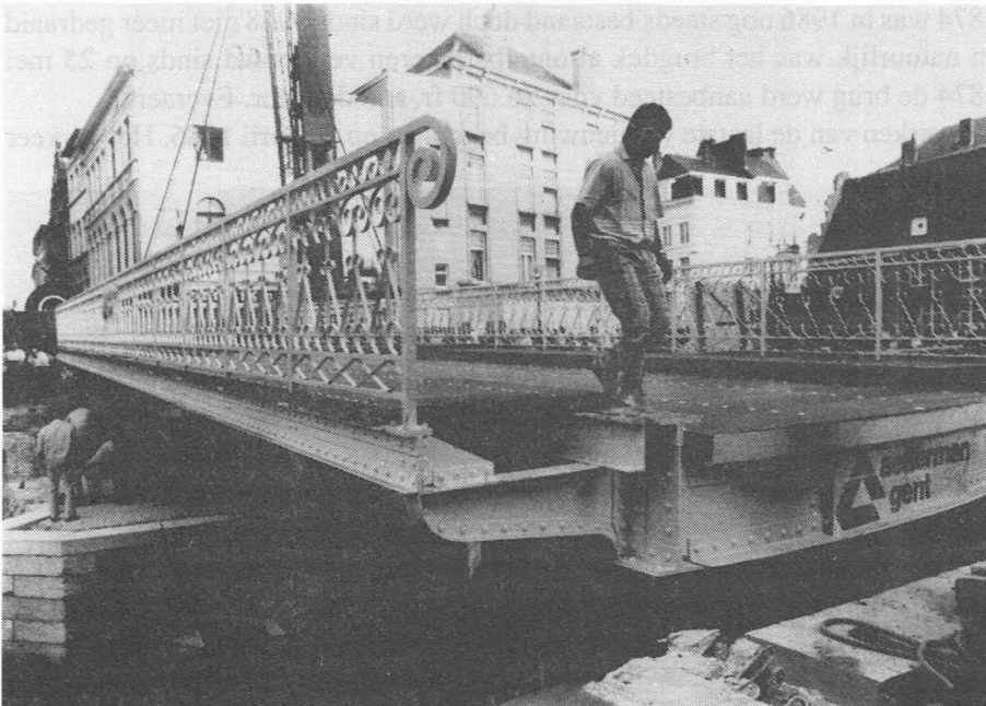
Plaatsing Zuivelbrug op 1 juli 1987. Foto ROL.
