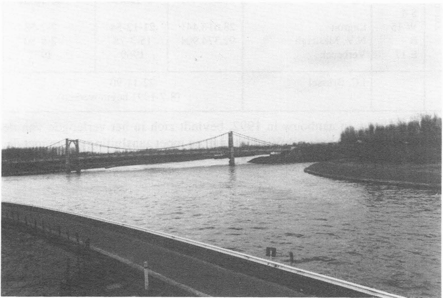
Ringvaartbrug W. 16 - Nieuwe Kalebrug Mariakerke.
