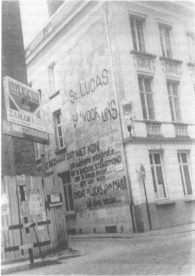
Fig. 8. Graffiti op de zijgevel hoek Schouwvagersstraat 1989 (Eigen foto).
