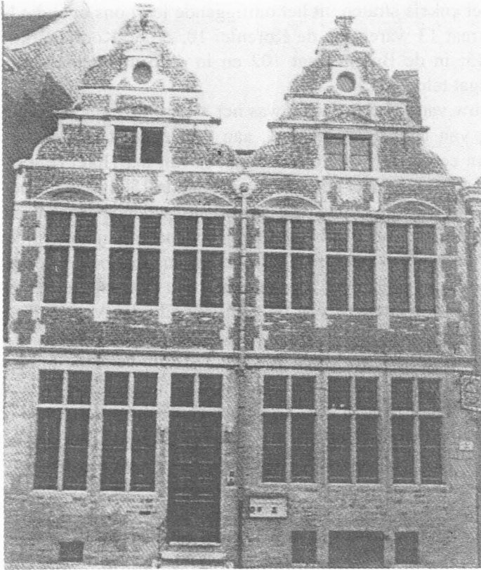
Fig. 12. De dubbele gevel in rode baksteen, Poel nr. 25.
