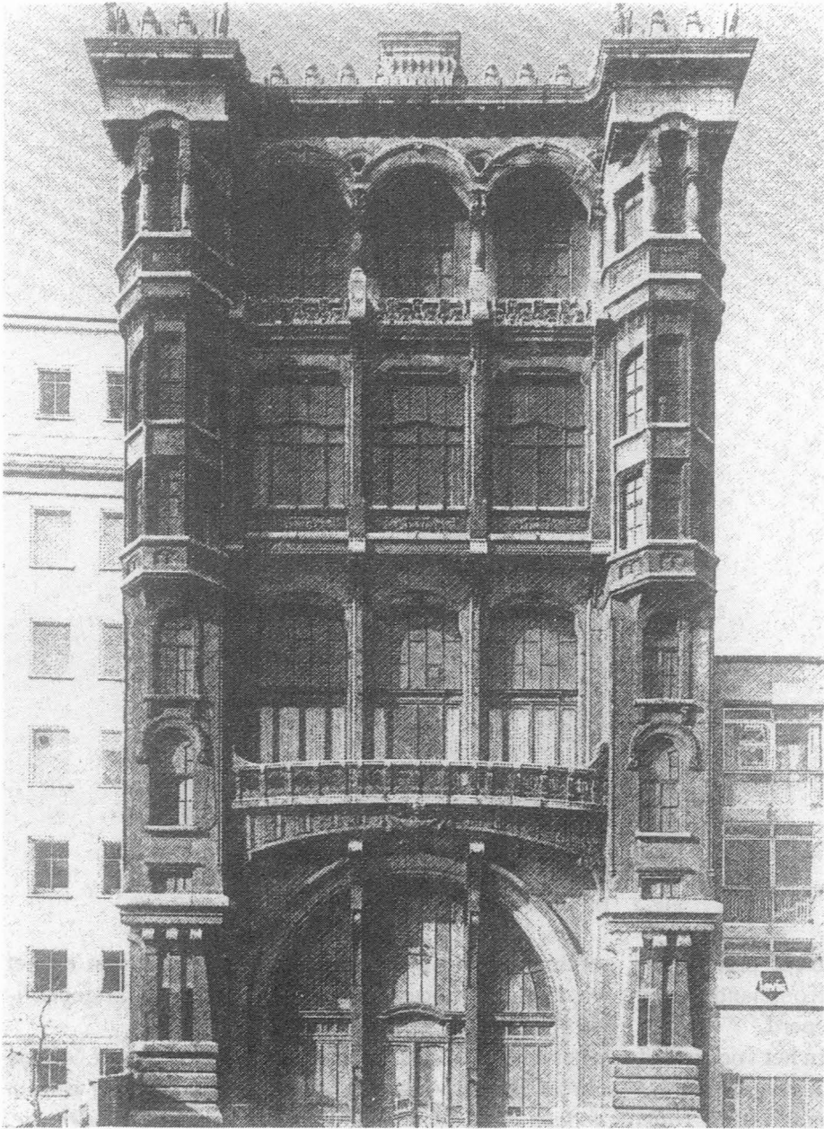
Fig. 4. Achtergevel van het Feestpaleis vóór de opknapbeurt.
