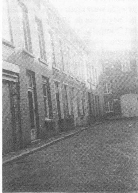
Fig. 25. Het Blindeken. Eigen foto 1993.
