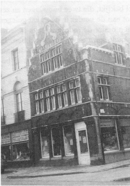
Fig. 26. Hoek Ramen/Burgstraat: Huis met trapgevel. Eigen foto, 1993.
