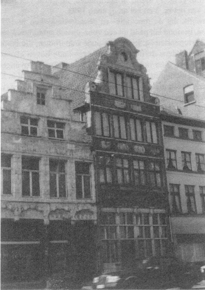
Fig. 7. Hoogstraat, panden nr. 3, nr. 5 (gerestaureerd in 1977-1978) en deel van nr. 7; Eigen foto 1993.
