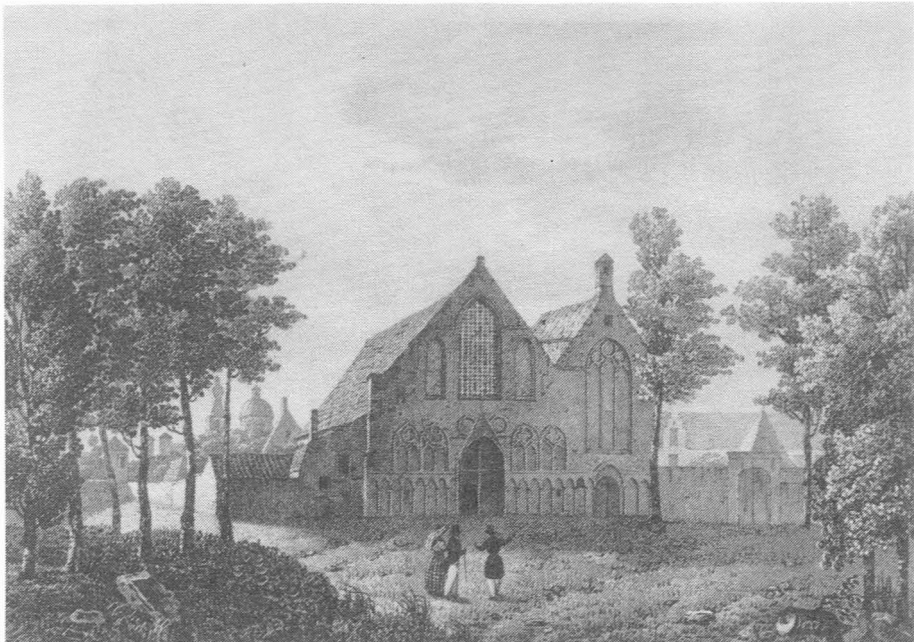
3. Het Hospitaal van de Bijloke.
