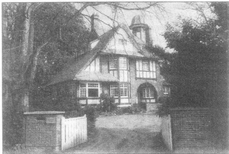
Kortrijksesteenweg nr. 1004, een ontwerp van Jules Hayaert uit 1912, voor notaris Van Schoote. Opmerkelijk is het raamtype. Merkwaardig is het parement hier uitgewerkt in vakwerk (Foto Erik Dekeyser).
