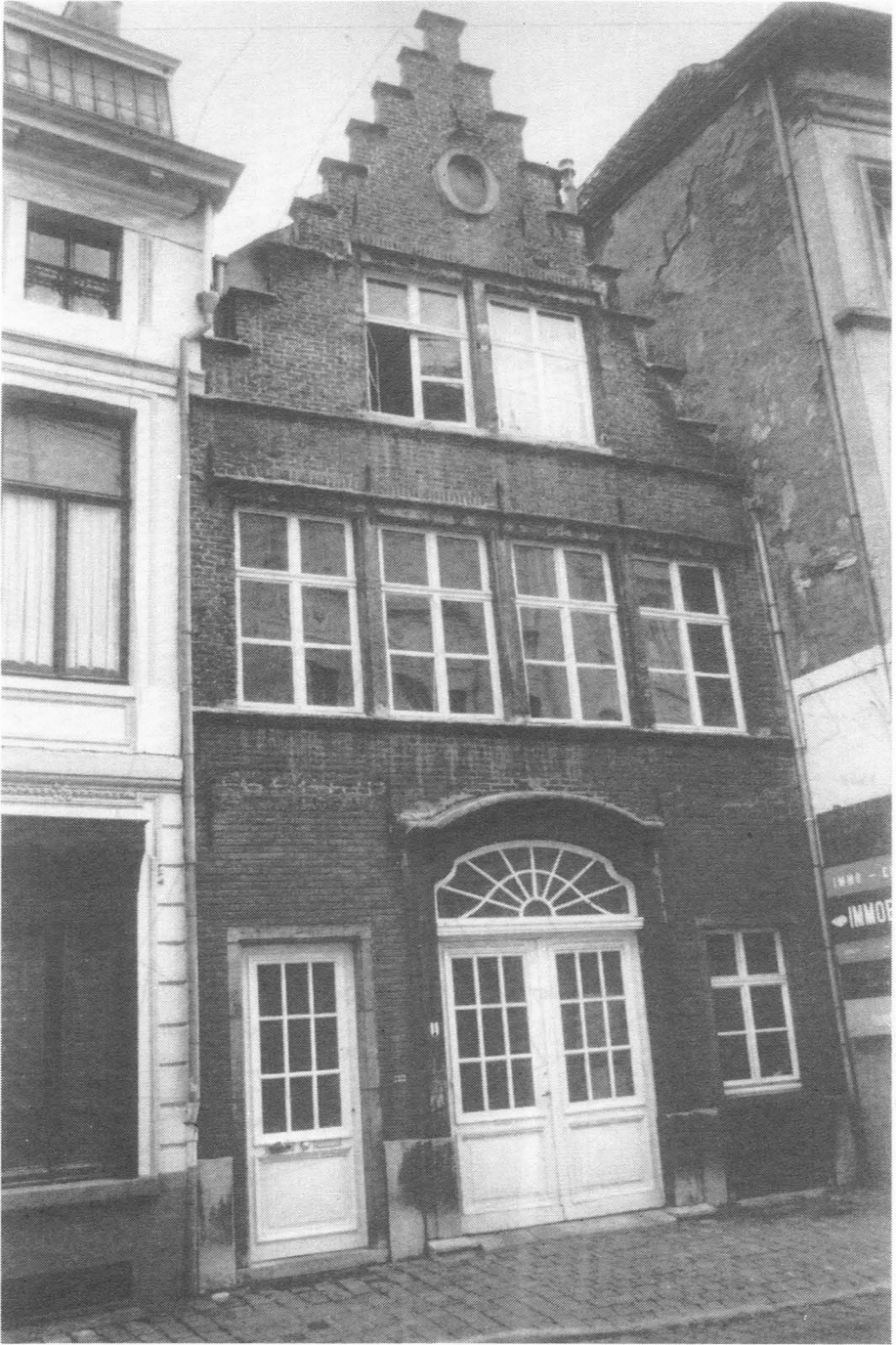
Afb. 4. Het 17 de -eeuws pand, Drabstraat nr. 11, toestand voor de afbraak (Foto RMLZ).
