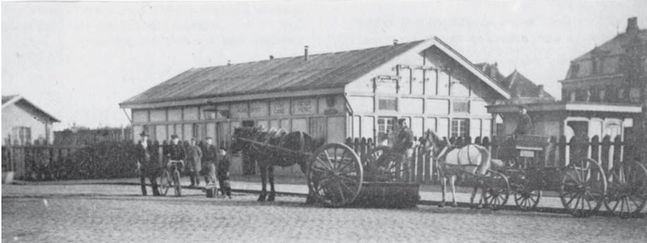
Eerste versie van het Sint-Pietersstation uit 1881 aan de Parkplaats. Uiterst rechts het paviljoentje met de “pissijnen” en “gemakken”, links een gedeelte van de in steen opgetrokken goederenloods.
