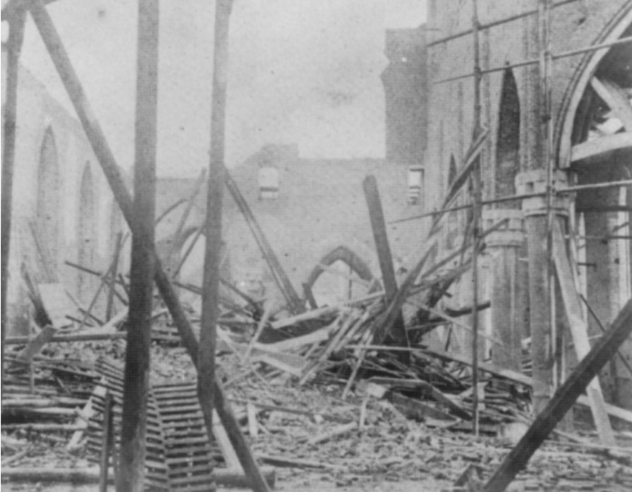
Afb. 2 1863. De Sint-Jan-Baptistkerk in aanbouw stort in
