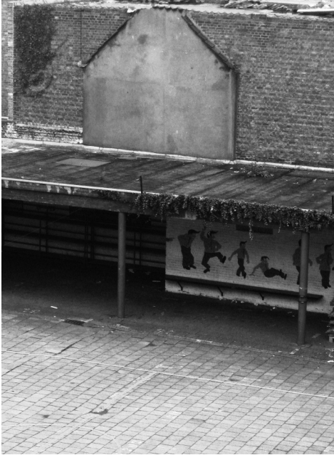
Gecementeerde gevel van het Braeckmanbeluik, thans speelplaats van het Hoger Technisch Instituut Sint-Antonius.
