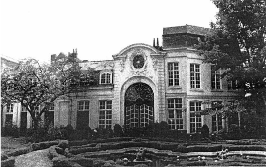
Hotel Verhaegen-Lammens Achterbouw. Tuingevel.
