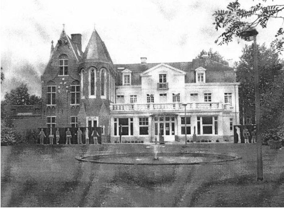
Kasteel Maaltebrugpark. Links de neo-gotische vleugel. Vooraan de fontein.
