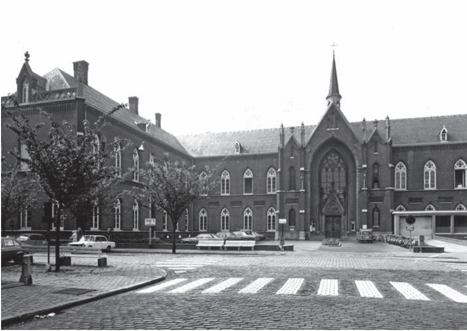
Ingang van het Neo-Gothiek gebouw van Adolphe Pauli (±1870)
