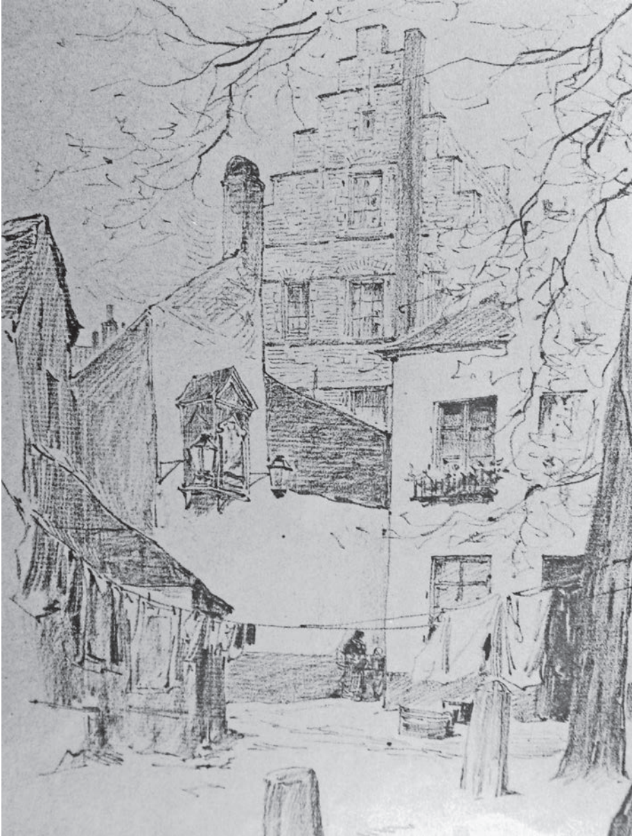
Afb. 1. Gevel van de zogenaamde brouwerij van het Rijke Gasthuis, nog daterend uit de leprozentijd, vermoedelijk uit het tweede kwart van de 16de eeuw, momenteel wachtend op restauratie (tekening Armand Heins, Stadsarchief Gent, Atlas Goetghebuer, L147).
