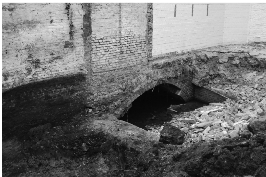
8 De 'Oude Schelde', ingekokerd aan de Hubert Frère - Orbanlaan (hoek Hendrik Waelputstraat), blootgelegd voor de bouw van een appartementscomplex. Moeilijk in te beelden dat dit nog een overblijfsel is van deze 'machtige, prachtige stroom' (foto A. Brysse, februari 2011).
