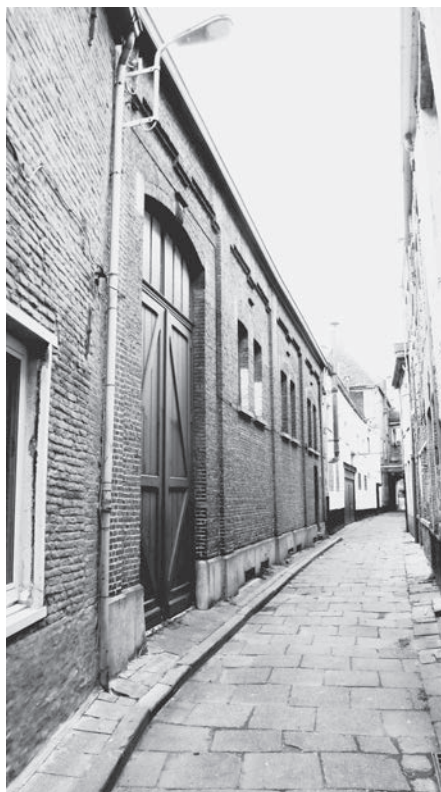
Afb. 4. Rechts: Garensteeg, voordien Engelsteeg en nog vroeger Contentast. Het Stantvedestraatje, dat verdween bij de grote kaalslag van de hele buurt in 1909, lag ter hoogte van de hoge poort links (foto 2014).
