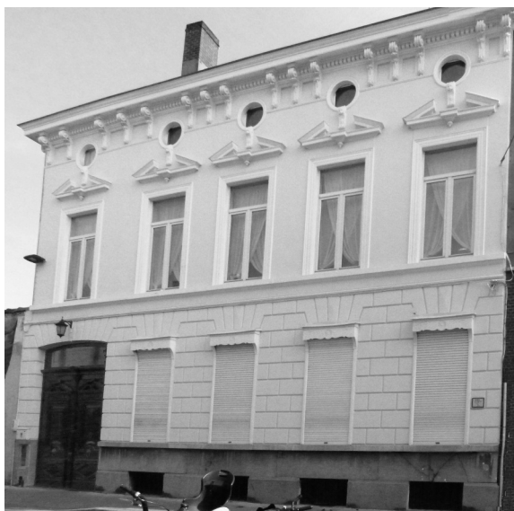
Afb. 2. Gerenoveerde gevel zonder opschrift (2015).
