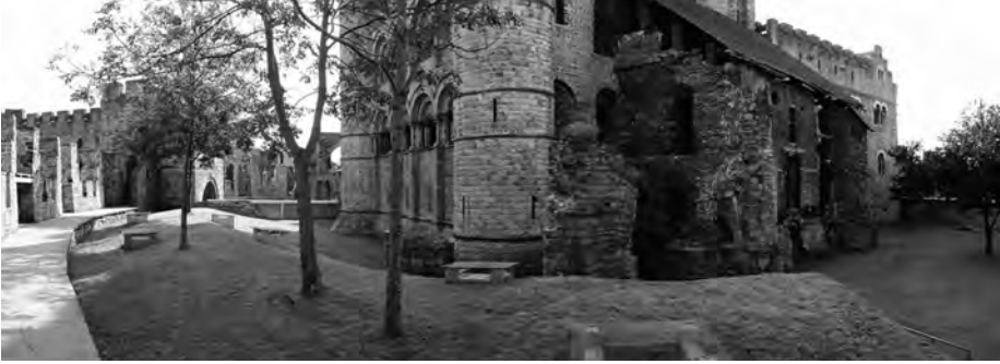
Voormalig griffiegebouw, Gravensteen, Gent
