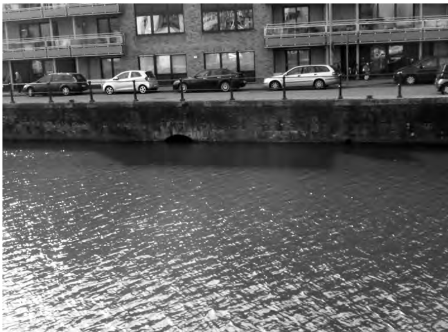
Afb. 7. Gezicht op de Koepoortkaai van op de Visserij (foto 2016). De overwelfde monding in de Schelde van de Schepenvijver bleef mooi bewaard in de kaaimuur. Gelukkig mondt er geen stinkende riool meer in uit. Dat was de prozaïsche reden waarom deze constructie bewaard bleef.
