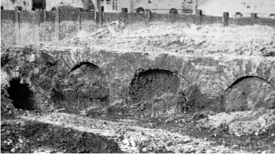
Afb. 5. De in 1846-1847 overwelfde Schepenvijver aan 't Stuk als ondergrondse aquaduct aan het licht gekomen toen in mei-juni 2009 de kelder van het nieuw te bouwen appartementencomplex Artevelde werd uitgegraven. Vergelijk de groote van de overwelvingen met die van de nog net zichtbare auto's op de straat (foto M. Hanson, 2010).
