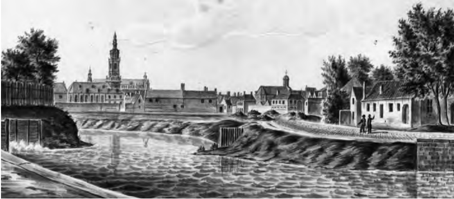
Afb. 1. Gezicht op de Nederschelde en de Koepoortkaai in de periode 1815-1830 door J. Wynantz (Stadsarchief Gent, Atlas Goetghebuer). Links de toren van de begijnhofkerk, midden het torentje van de Sint-Katarinakapel, destijds aan de Lange Violettestraat, rechts enkele huisjes aan het Capucijnenvaardeken ongeveer op de plek waar Spilthoorn zijn stokerij zou starten.
