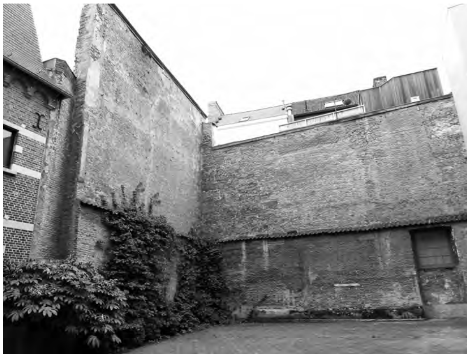
Afb. 9. Van op de binnenkoer van het pand Sint-Baafsplein 10 (Hotel van Brantegem) kan men nog goed het volume inschatten van het verdwenen gebouw, met links de binnenzijde van de bewaarde zuidgevel en rechts de vermoedelijk bewaarde westelijke langsgevel (foto Jos Tavernier, 2016).
