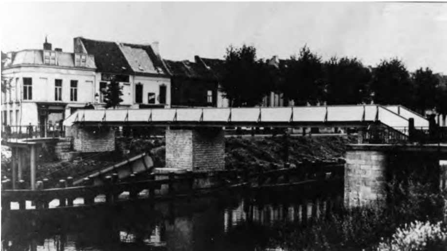
Noodbrug over de Brugse Vaart ter vervanging van de door het Belgisch leger in mei 1940 opgeblazen Hamerbrug. ('Zwarte Doos' Gent)
