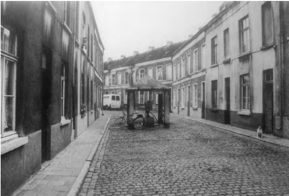
Afb. 5. Een gedeelte van het steegbeluik Cité Anglaise of Oud kerkhof met opvallende gemeenschappelijke pomp midden op 'straat'. Die werd beschouwd als binnenplaats en was geen stadseigendom (foto genomen in 1981, verzameling Roger Moreau, gereproduceerd in Archiefbeelden Gent, deel VI, 2005, p. 118).
