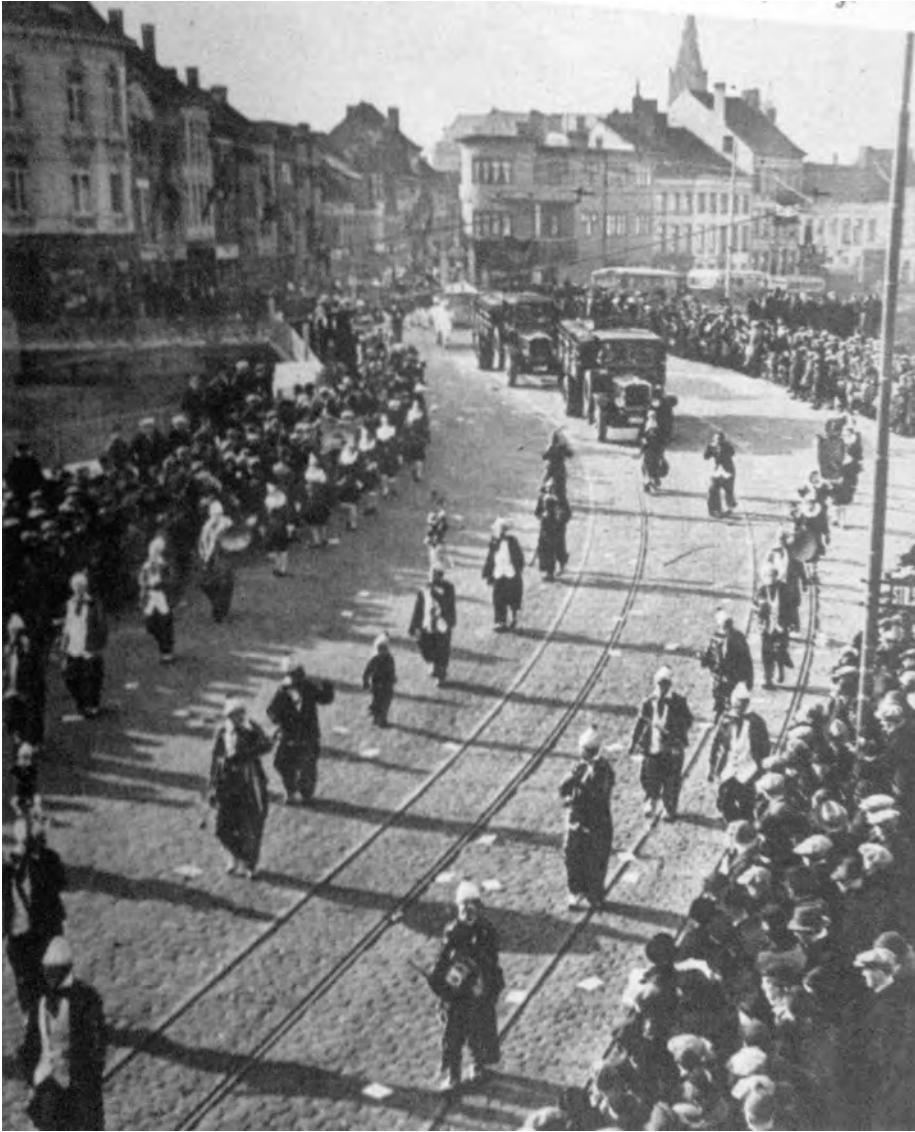
Afb. 3. Een carnavalstoet trekt over de nog niet ingehuldigde nieuwe brug (foto uit het weekblad De Stad van 15 maart 1935 (collectie DSMG)). Vergelijk met afb. 1 en bemerk het dubbele tramspoor.
