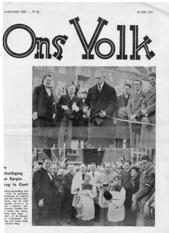
Afb. 2. Inhoudiging en inzegening door wereldlijke en kerkelijke overheden van de nieuwe, aanzienlijk verbrede brug in mei 1935. Op de bovenste foto: de liberale burgemeester Vander Stegen met buishoed, lint en schaar. Op de onderste met wijwater en kwispel: bisschop Coppieters en de geestelijkheid in kerkelijke gewaden. Toch was de scheiding tussen kerk en staat ‘op zijn Belgisch’: niet volledig. Sommige lezers zullen rechts van de burgemeester wellicht de katholieke politicus De Schryver herkennen. Die had toen als minister, eerst van Landbouw, daarna van Binnenlandse Zaken, heel wat in de pap te brokken. Enkele nevenfiguren prijken op beide foto’s (collectie Vliegende Bladen-Gent in DSMG).
