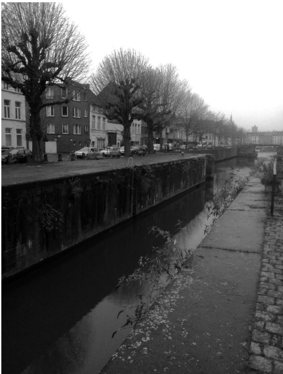
Afb. 4. De half ontmantelde Kasteelsluis in 2016.
