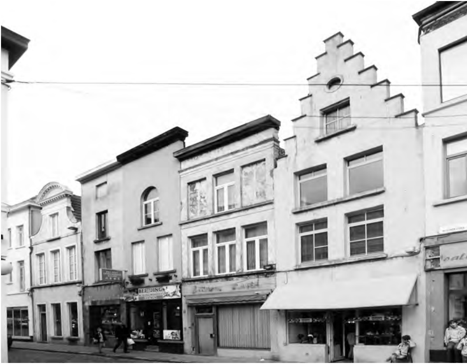
Afb. 2. Een gedeelte van de noordelijke straatwand (foto 2014). Het Minnemansteegje lag iets meer naar links (buiten beeld). Bemerkt de bovenpartijen van de gevels die de vorm van de oorspronkelijke tuit- of trapegevels verraden.
