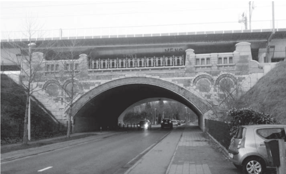
Afb. 19. Aan de zijde naar Sint-Denijs van de Sneppebrug werd de oude brug op een slimme manier geïntegreerd in een constructie die de oversteek van de Leie mogelijk maakt voor fietsers en voetgangers. De spoorbrug zelf ligt een eind hoger (foto 2017). Aan de stadszijde vertoont de nieuwe Sneppebrug een fraaie sobere boog. Dit alles naar ontwerp van arch. Ph. Samyn en partners samen met Infrabel (NMBS).
