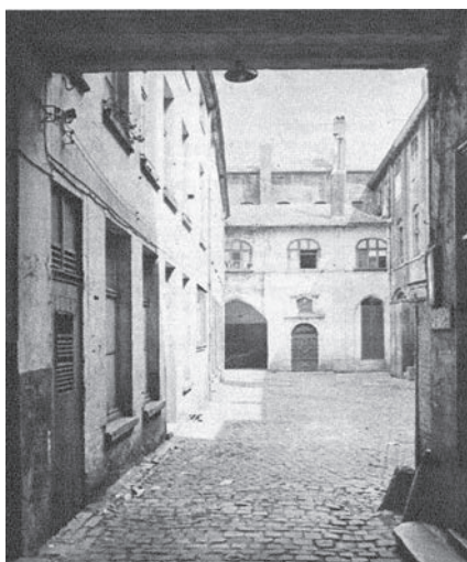
Afb. 2. Binnenkoer (De Stad, 23 juli 1937) toen het Pand er nog redelijk proper uitzag.
