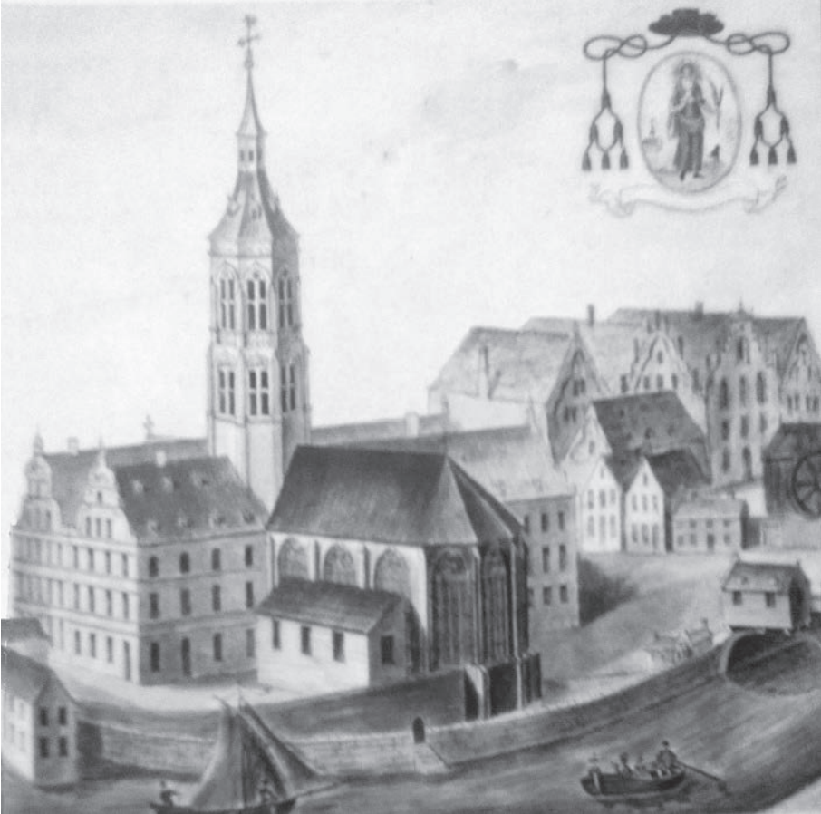
Afb. 4. Dezelfde kerk (toen ex-kerk) tien jaar later (1590, aquarel door P.J. Goetghebuer, Stadsarchief Gent, Atlas Goetghebuer L41-20, hier anders geïntendeerd dan bij afb. 3). Het gebouw werd omgevormd tot o.m. twee grote huizen aan het Sint-Veerleplein (links). Rechts de kraan en enkele huizen van de Kraanlei.
