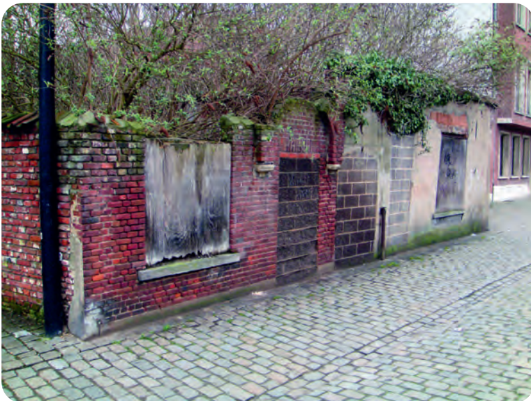
Afb. 15. Toestand in 2011 van dit bijna volledig afgebroken stukje erfgoed. De drie deuropeningen van afb. 14 zijn nog goed herkenbaar. Bemerkt de rooilijnverlegging uiterst rechts: fataal voor alle oude bebouwing en een schoolvoorbeeld van wat niet zoveel jaren geleden nog moest en nu gelukkig niet meer mag...
