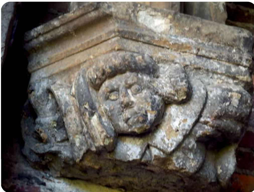
Afb. 2. Een van de minst aangetaste kapitelen in de pandgang van de Sint-Baafsabdij, 15de eeuw. Foto 2021.
