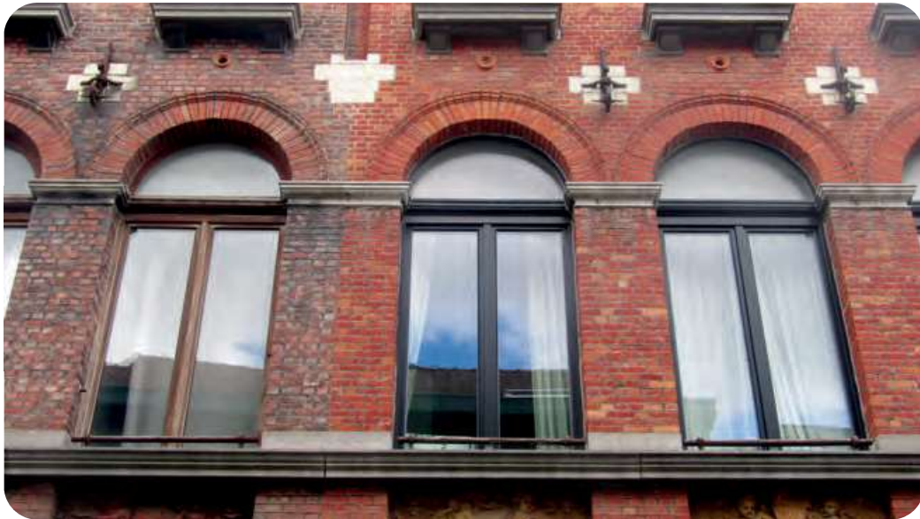
Detail van de rondboogvensters.
