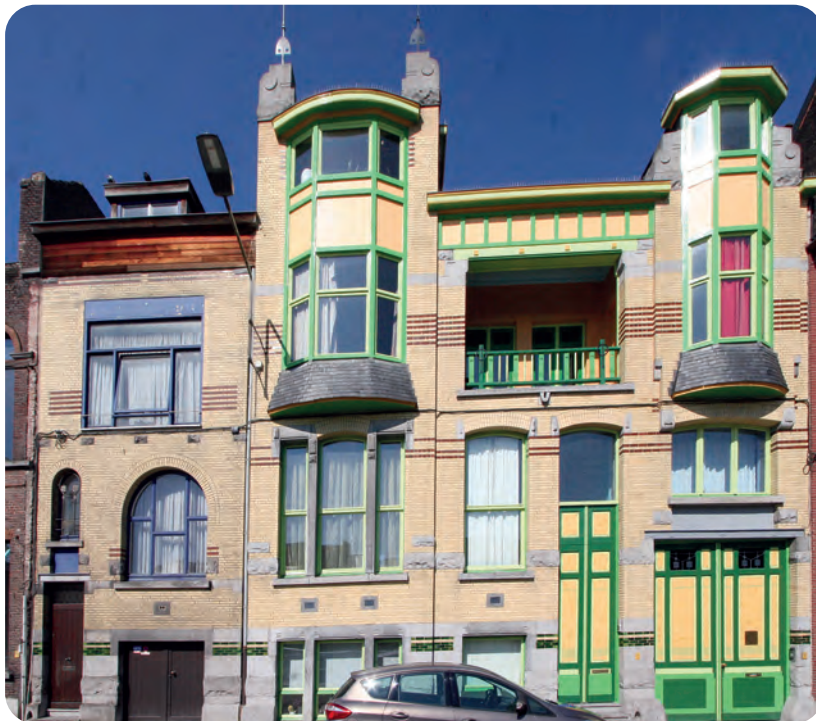
Afb. 4. Huis Dael. Voorgevel aan de Visserij (foto A. Brysse, 2021).
