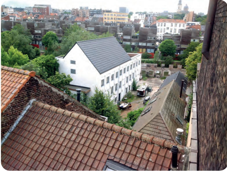
Afb. 5. Luchtfoto met centraal de wit gekaleide gerestaureerde lange vleugel van de brouwerij Hebbelinck (ongedateerde foto G. Janssens).
