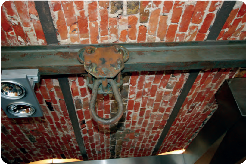
Afb. 8. Troggewelven in baksteen gemetseld tussen ijzeren I-vormige balken (foto A. Brysse, 2021).
