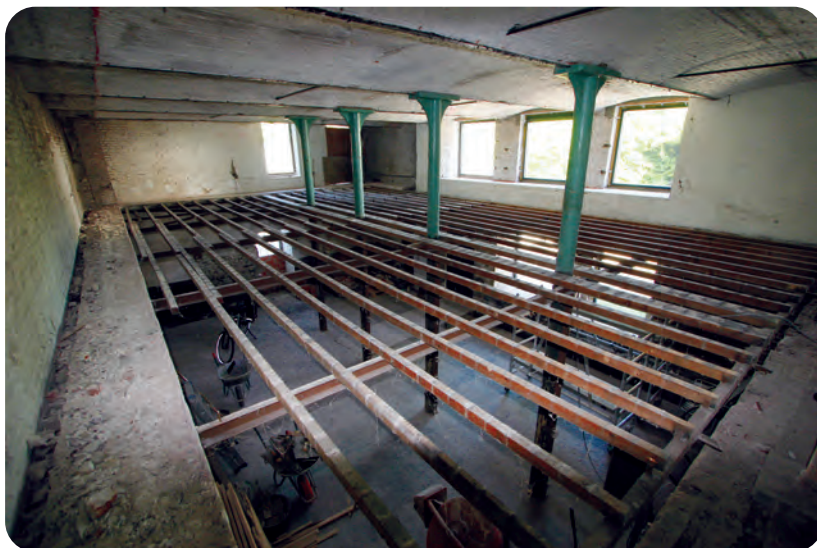
Afb. 7. Roostering voor de troggewelven tussen het gelijkvloers en de eerste verdieping (foto A. Brysse, 2021).
