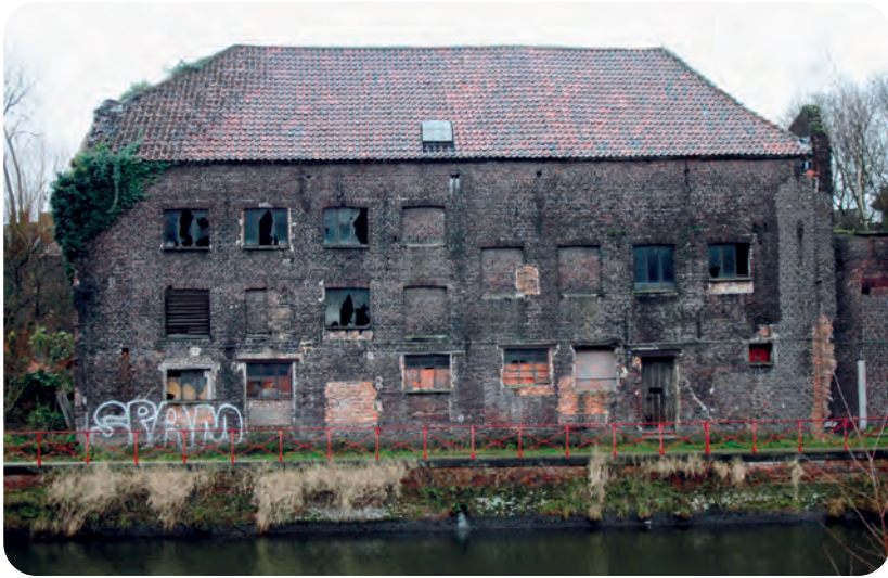
Afb. 3. De al bouwvallige korte vleugel van de brouwerij langs de Achtervisserij aan het einde van de vorige eeuw. Een toegangsdeur is dichtgemetseld. Links op de eerste verdieping zien we nog een raam met lamellen. Om het wort in de ondiepe gietijzeren koelbak sneller af te koelen werden aan twee kanten van de bak de vensterlamellen opengezet. Zoals op afb. 2 te zien, bleef van dit gebouw enkel het onderste gedeelte van de buitenmuur aan de Achtervisserij bewaard als terreinafsluiting (ongedateerde foto G. Janssens).
