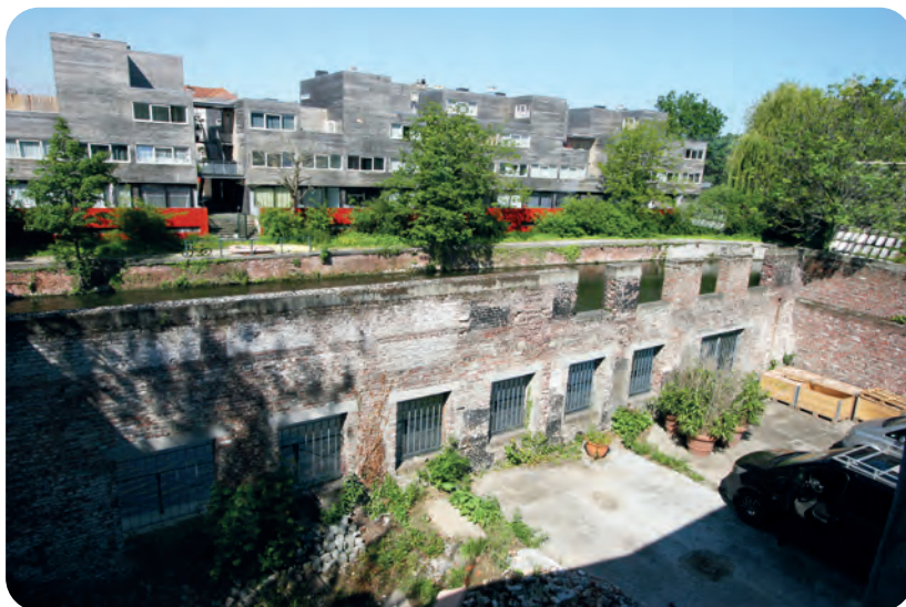
Afb. 2. Ligging aan de tragel (trekweg: Achtervisserij), rechtover het sociaal wooncomplex Hollainhof op de andere Scheldeoever. Foto (A. Brysse, 2021), genomen vanop de oude brouwerij. Tussen beide is de kaai aan de overkant en nog net een streepje Scheldewater te zien.
