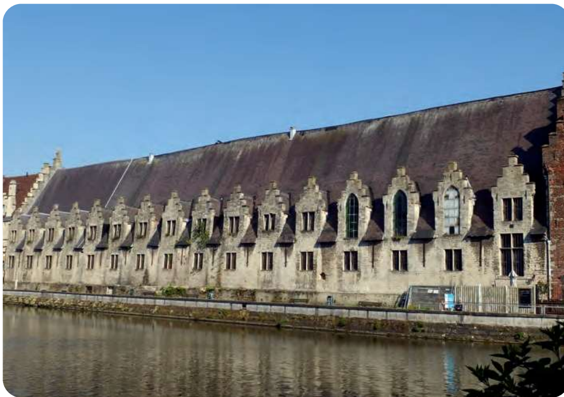
Afb. 2. Westgevel van het Groot Vleeshuis, gezien vanop het Appelbrugparkje aan de Jan Breidelstraat (foto 2020). Bemerkt de drie grotere spitsboogramen in de dakkapellen rechts: locatie van de ‘kapel’ en vergaderzaal van het ambachtsbestuur. Uiterst links zijn nog net de trapjes van de geveltop van het neringhuis van de visverkopers te zien.
