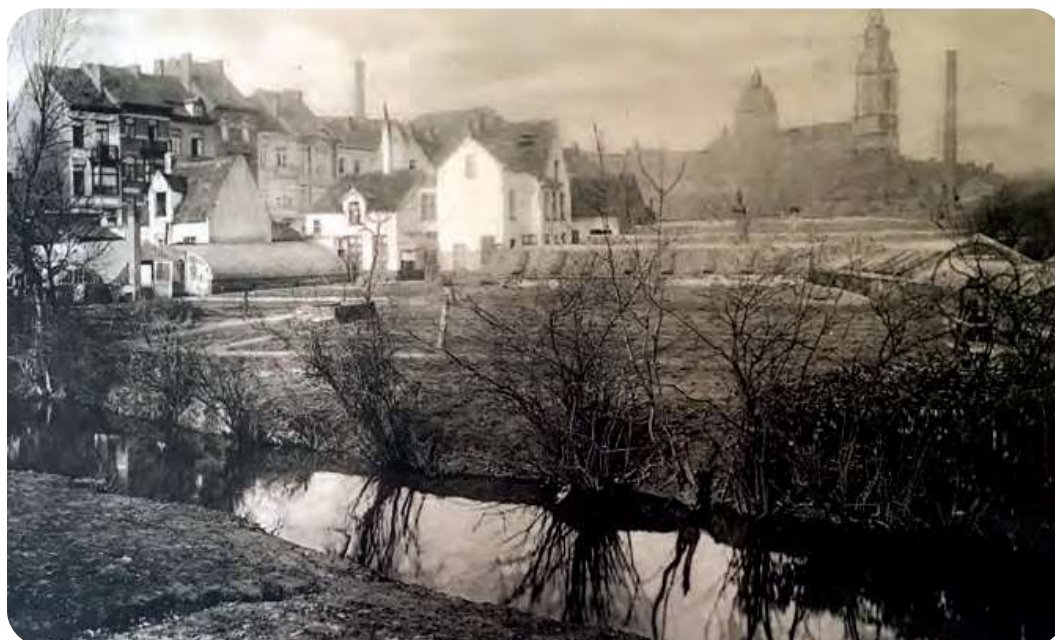
Afb. 6. Oude Schelde aan de vooravond van zijn verdwijning. Achteraan links: één zijde van de Willem Wenemaerstraat in opbouw met er voor nog een rest van het gehucht Oude Molenaarstraat. Rechts het silhouet van de Sint-Pietersabdijkerk met – heel typisch – een hoge fabrieksschouw ernaast. Overgenomen uit Bergmans en Heins (1913).
