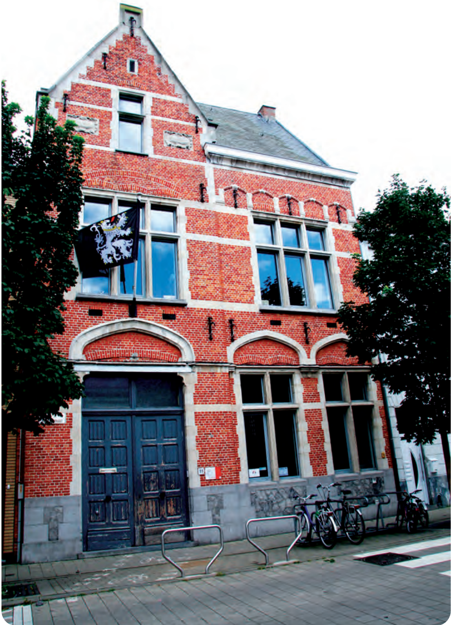
Een van de twee toegangen tot de Jenaplanschool De Feniks, gebouwd in 1899-1904 in de Acaciastraat, zijstraat van de Phoenixstraat, naar ontwerp van Charles Van Rysselberghe (archief van De School van Toen vzw – foto Rudolf Roels, 2019)
