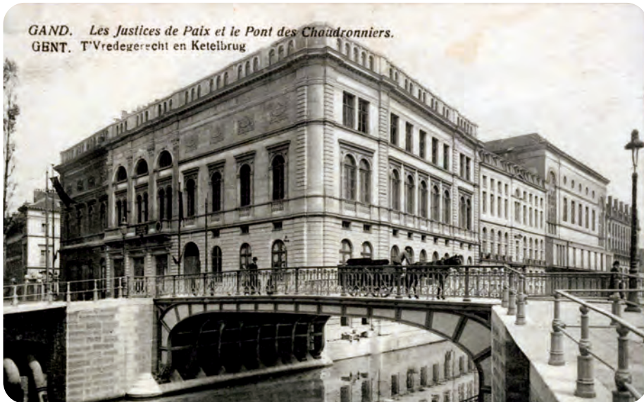
fb. 9. Zicht op de Ketelbrug en de gebouwen aan de Ketelvest, begin 20ste eeuw. De vierde gevel (achter de lantaarn) is een zeldzaam zicht op de achtergevel van het Posthotel. Alle gevels zijn realisaties van Charles Van Rysselberghe. Net zoals aan de Kouter, trachtte de architect hier 'de fysionomie' van de omgeving te respecteren. Zo is de gevel van het gewezen Vrederegerecht niet meer dan een kopie van de gevel van de Opera, een ontwerp van Louis Roelandt. Bron: Beeldbank Stad Gent.
