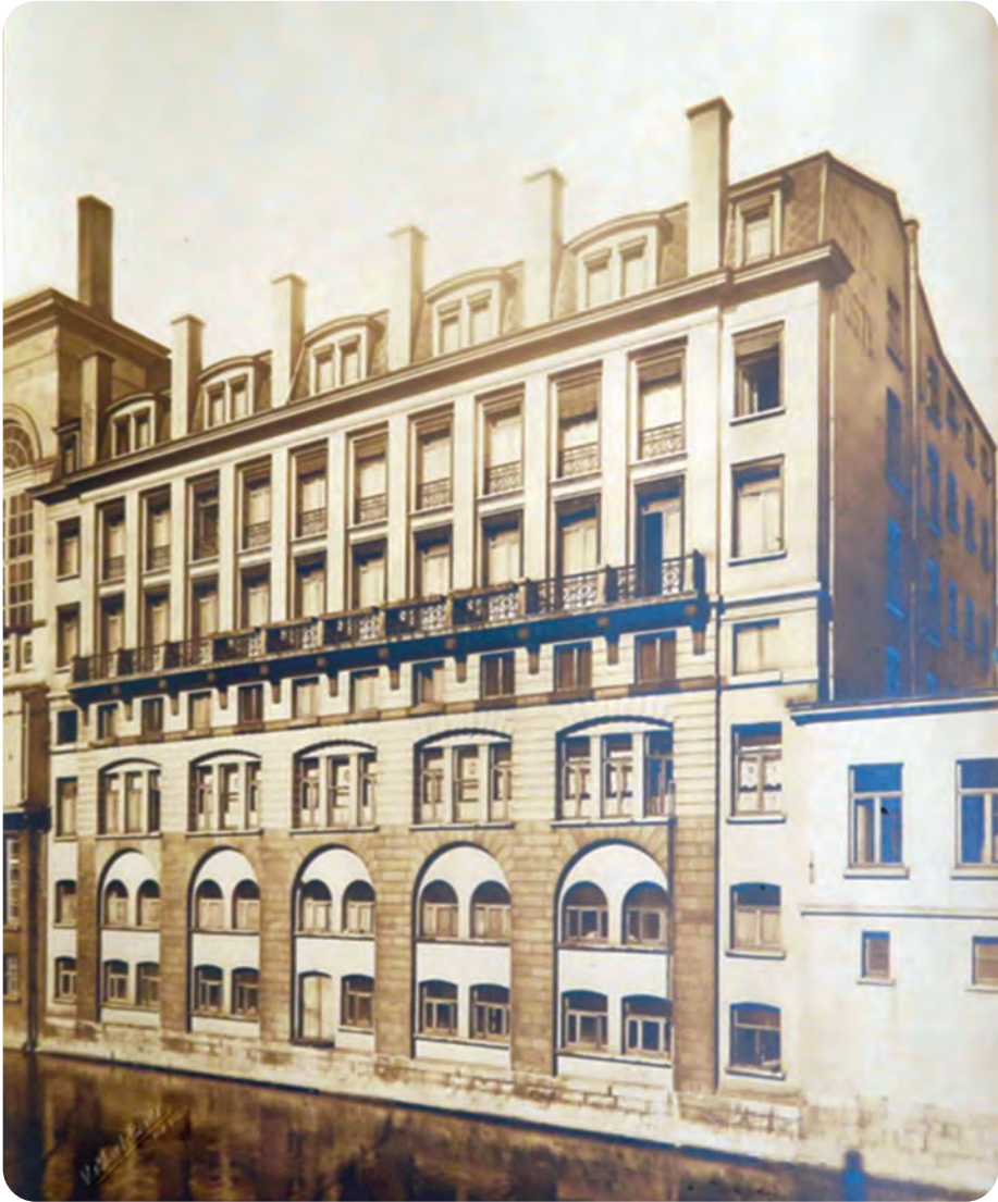
Afb. 8. Achtergevel van het Posthotel, ca. 1925, fotograaf. Vandersypt-Boute. Bron: Stadsarchief Gent. romVII 1643_4/1925)
