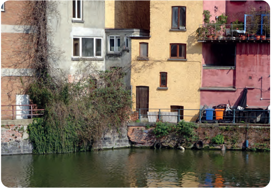
Afb. 3. De opbouw van de kaaimuur verraadt de plaats waar de Oude Schelde vroeger de Muinschelde ontving: links grote blokken kalksteen, rechts baksteen (foto 2018). De Oudescheldestraat wijkt daarvan af. Hier was een van de twee walen (wielingen) gelegen.
