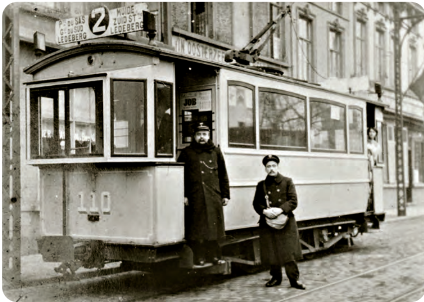
Afb. 4. Een Gentse twee-asser een jaar later, nu met door een windscherm afgesloten platforms. Omwille van de ruimte nodig voor de handremzwengel is het windscherm als een uitbouw geplaatst, waardoor de volksmond die preekstoeltrams noemde.
