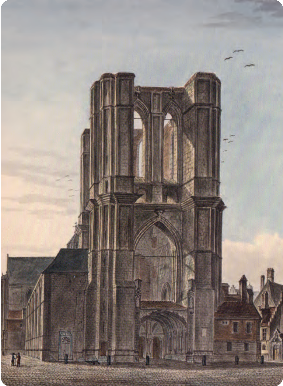
Afb. 7. De bekende Sint-Michiëlstorenstomp zoals gezien door de Brusselaar Wynantz in de Hollandse Tijd, omstreeks 1820 (overgenomen uit Kleurrijk. Wynantz en Gent, Snoeck & Zwarte Doos ). Bemerkt de grote vensteropeningen zonder glas en het primitieve dakje boven de overwelfde buitenste ingangspoort. Het schip van de kerk was toegankelijk voor de gelovigen via twee afsluitbare deuren achterin de open 'torenhal'. Uiterst rechts een stukje van het in een vorig GT-nummer beschreven Hof van Ravenstein.
