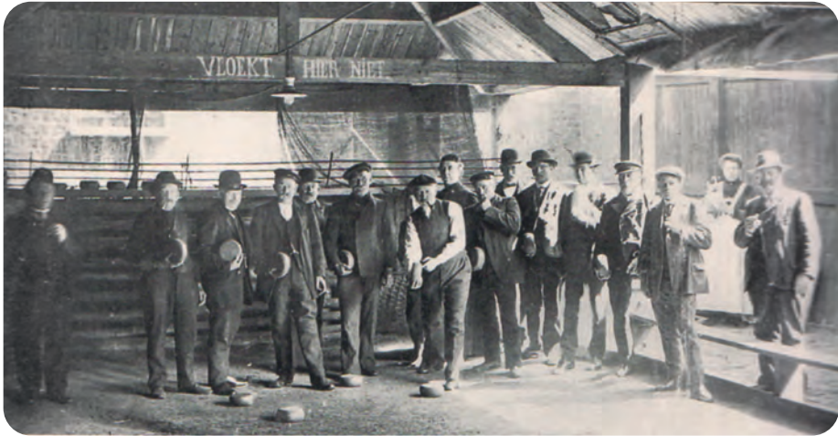
Afb. 1. Het schipperswerk was niet enkel religieus en educatief, het was ook sociaal en recreatief. Zo werd er vanaf het begin voorzien in een overdekte bolbaan voor het bij de schippers zeer geliefde krulbolspel. Om publiek te trekken moest het Schippershuis daarover beschikken. Die werd ingericht achter het Schippershuis. Rechts op de achtergrond, de enige persoon zonder hoofddekse: de schippersaalmoezenier. In plaats van Hier vloekt men niet, staat er dwingend: Vloekt hier niet. (Foto uit 1921 in DSMG, collectie Vliegende Bladen – Gent, ‘Straten’: Dok-Noord. Schipperskapel. Schenking Huguette De Bleecker-Ingelaere)
