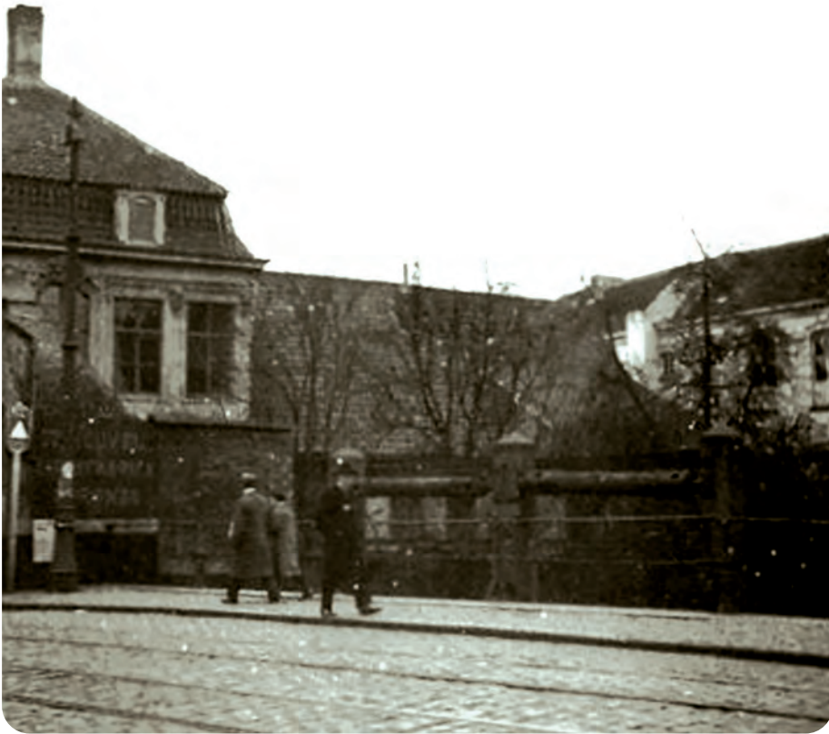
Afb. 2b. Rechts westelijk gezicht. Ook al lang verdwenen.
