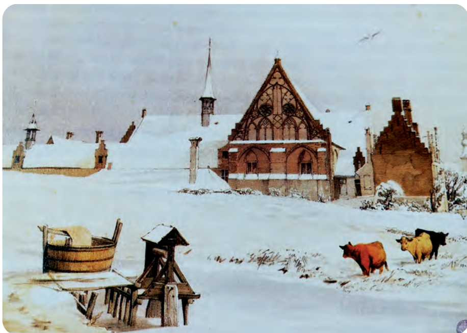
Afb. 6. In dit sneeuwlandschap komt het unieke baksteenmaaswerk van de westgevel van de refter van de Bijloke abdijskerk goed tot zijn recht. Probeer je in te beelden dat het verkeer over de de stadsring ter hoogte van de Godshuizenlaan nu de plaats inneemt van de koetjes die hier naar hun drenkplaats trekken (Archief Gent – Zwarte Doos).
