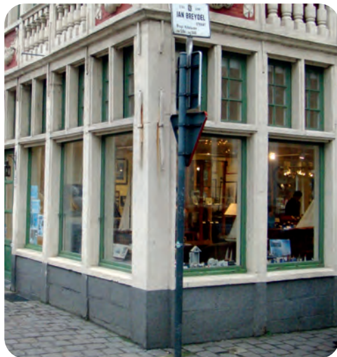
Afb. 7 links. Detail van de geveltekening van de gevel van Burgstraat 2 door arch. Amand Janssens (Archief Gent, reeks G). Men kan nu nog goed zien dat de vensters op de twee verdiepingen van elkaar gescheiden zijn door nauwe kolommen, opgebouwd uit witsteen blokken, zoals op de tekening weergegeven.
