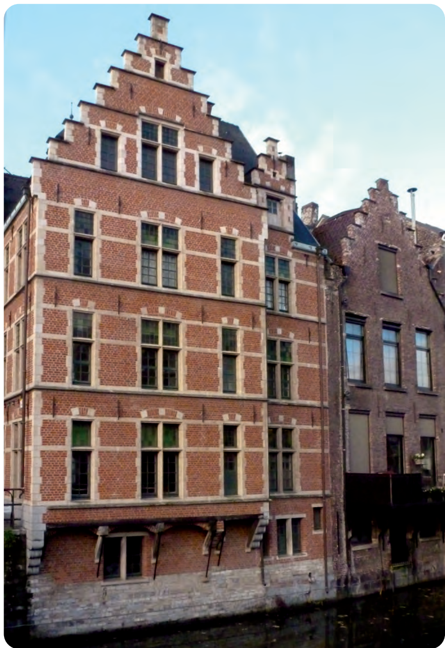
Afb. 8. Lievegevel van Burgstraat nr.2 (foto 2019). Dit lijkt helemaal niet op een achtergevel. De gevelopeningen zijn merkwaardig: drie bouwlagen met middenin telkens een kruisvenster geflankeerd door zogenaamde kloostermonelen (tweelichten: met een enkel onder- en bovenlicht). Beslist origineel... Rechts een niet uitkragend huisgedeelte met een dakkapel, samen met de 'onopgepoetste' achtergevel van het buurhuis.
