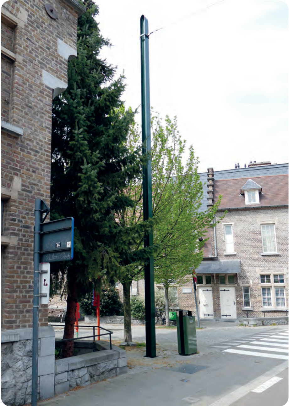
Afb. 4. Gerestaureerde en opgefriste paal: van tram naar verlichting (foto april 2019).
