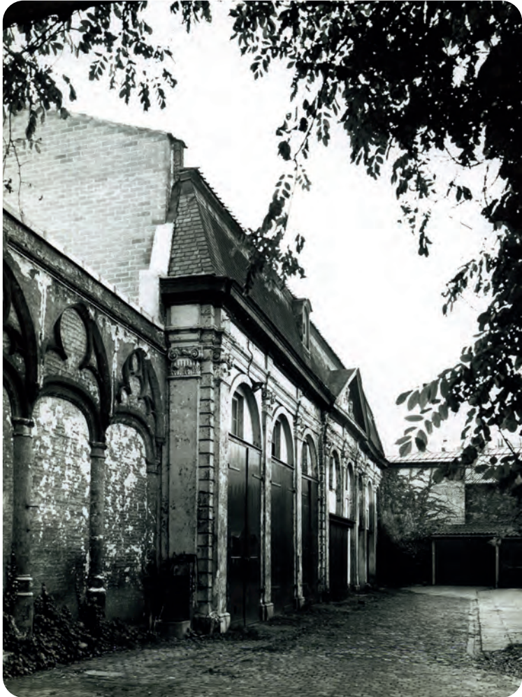
Afb. 9. Niet gerestaureerd uitzicht op de binnenkoer met links een deel van de dichtgemetselde galerie en rechts koetshuizen verminkt door banale garagedeuren. Ongedateerde foto (vermoedelijk laatste kwart van de vorige eeuw) in DSMG – Begijnhof Sint-Amansberg, schenking Columbian.
