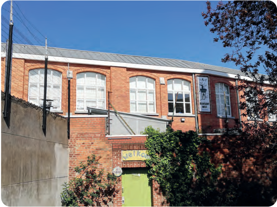
Afb. 4. De school uit 1887, ontworpen door Charles Van Rysselberghe (Archief Gent bouw-aanvragen Stad Gent, Lastencohier nr. 580), bijna onzichtbaar in de Kaprijkestraat, maar achterin des te beter (foto 2019, genomen bij het kerkje aan de Blaisantvest).
