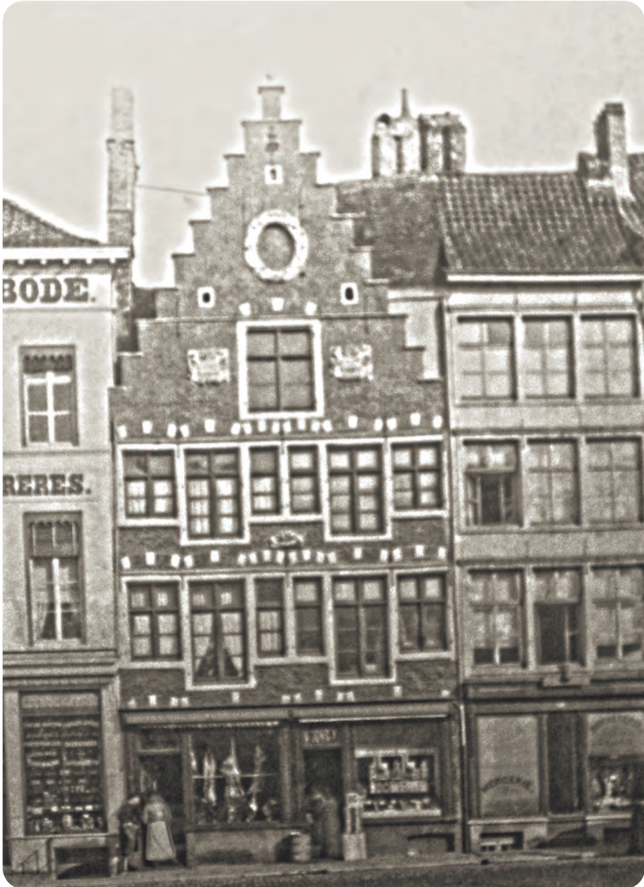
Afb. 1. De Grote en de Kleine Steur, nog herkenbaar als handelspanden aan de twee winkeldeuren en niet minder dan vijf verlaagde vensters, waarlangs goederen konden opgehesen worden (foto vermoedelijk genomen in de 19de eeuw, Stadsarchief Gent verzameling SCMS nr. 2013).
