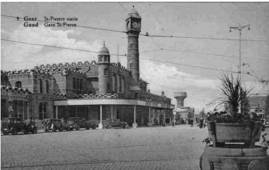
Voorgevel met de “marquise” uit 1932 en de pas afgewerkte watertoren.
