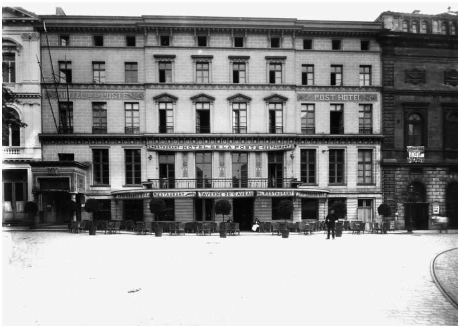
“Hotel de la Poste”.
