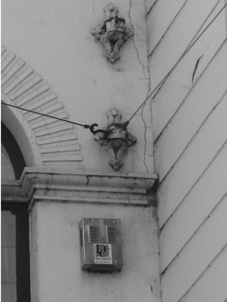
Sierlijke rozetten uit 1920 boven de ingang van “Tierentijn” aan de Groentenmarkt. Daarop werden de spankabels voor de bovenleiding van de tram bevestigd.
